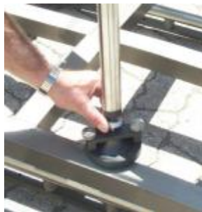
Nivellieren und Sichern der Stellschrauben
